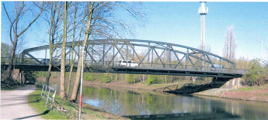
Uechtingstraßen-Brücke, Ansicht von Osten. Foto: LWL-DLBW, 2016.
