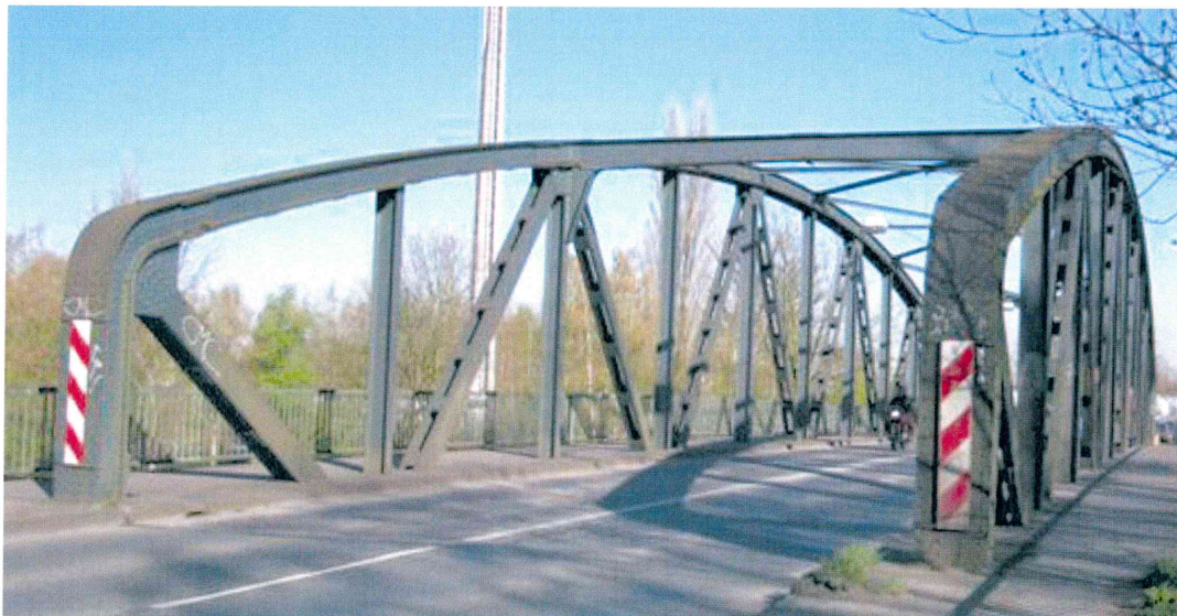
Ansicht von Süden. Foto: LWL-DLBW, 2016.
