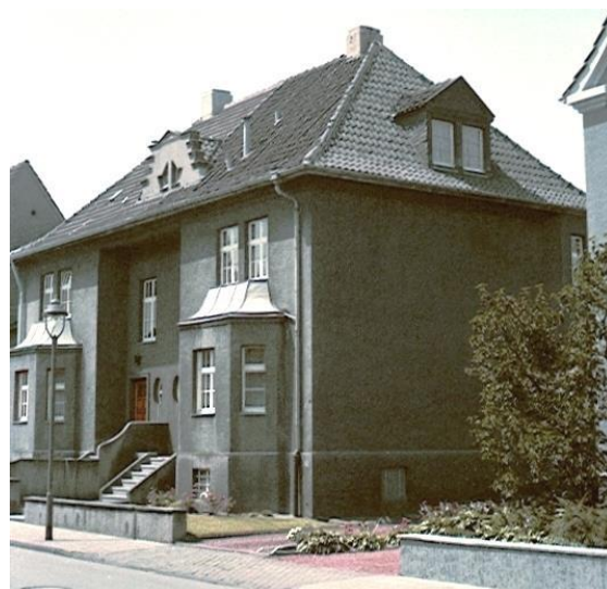
Zustand des Doppelhauses um 1960.
