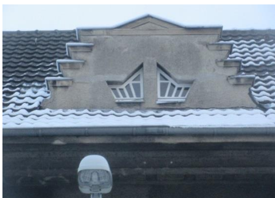
Das gemeinsame Dachhäuschen mit den Fenstern für die Badezimmer, Zustand Januar 2019.
