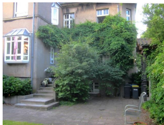
Gartenansicht mit veränderter Außentreppe und neugestalteten Fenstern im „Anbau“ von Nr. 17.
