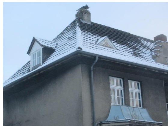
Dachzone von Nr. 17.
