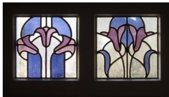
neue, um 1985 angefertigte Verglasung der Haustüre von Nr. 17.
