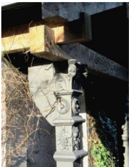
eine wiederverwendete Gußeisenstütze beim Gartentor von Nr. 17.
