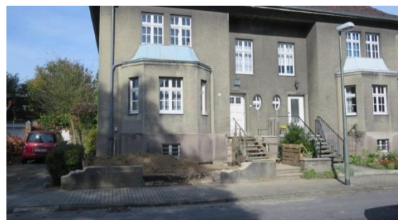
Abbruch der Vorgartenmauer und der ebenfalls erst um 1960 angelegten Hauszugangstrep- pen.
