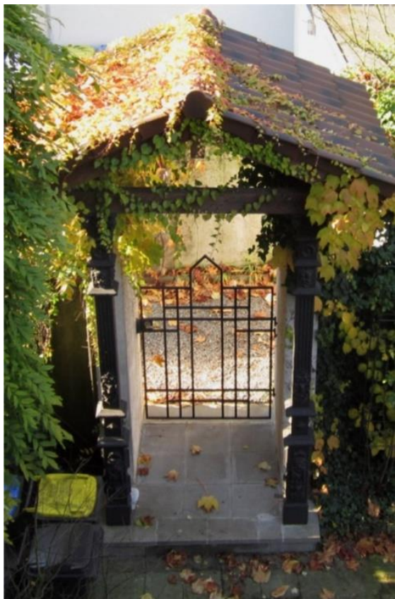
Die 1995 errichtete neue Abschlussmauer zwischen Haus und Garage bei Nr. 17 mit Tor und Gittertüre.
