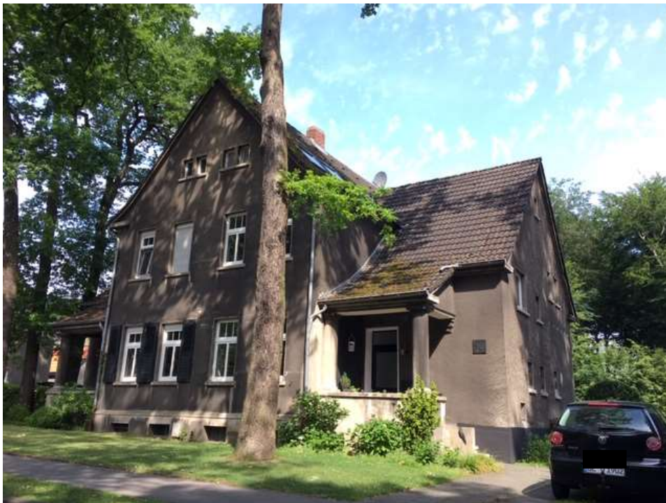
Abb. 2: Eingang Velsenstraße 16 Aufnahme: UDB, 2019
