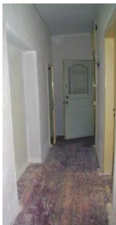
Abb. 10: Terkampstraße 7 (Cäcilienstraße 14 Erdgeschosswohnung. Flur mit Blick auf die Wohnungstür Aufnahme: LWL, 2017.
