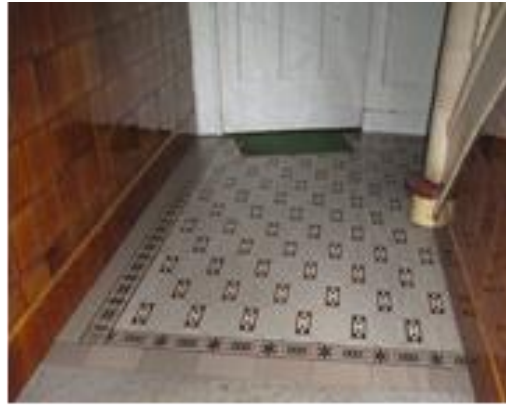
Abb. 06: Boden- und Wandbelag im Eingangsbereich des Treppenhauses Aufnahme: LWL, 2017.
