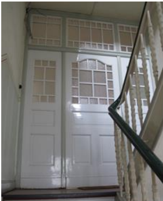
Abb. 07: Schierwand im Treppenhaus Terkampstraße 7, (Cäcilienstraße 14) Aufnahme: LWL, 2017.
