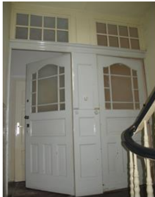
Abb. 08: Schierwand im Treppenhaus Schulz-Briesen-Straße 9 (Cäcilienstraße 14a) Aufnahme: LWL, 2017.
