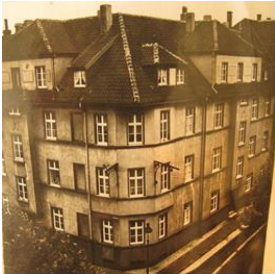
Abb. 01: Fassadenansicht, Aufnahme, undatiert., vermutlich vor dem 2. Weltkrieg Quelle: Bauaktenarchiv der Stadt Gelsenkirchen, 2017
