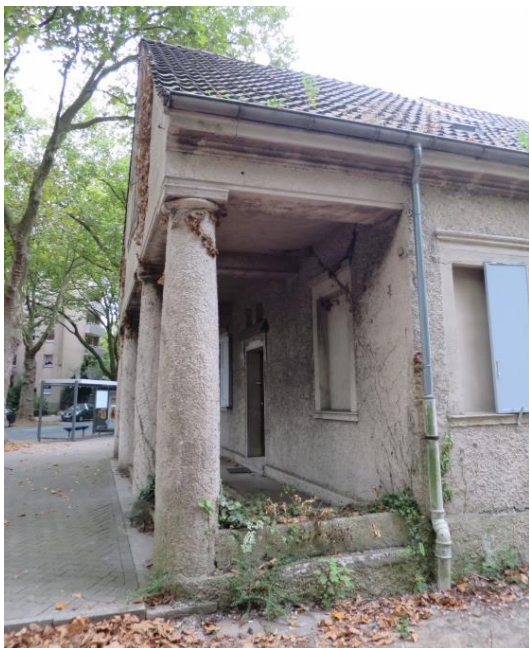
Abb. 06: Verwalterhaus Südfriedhof, Portikus von Westsüdwest Aufnahme: DLBW/Kirchhoff, 2016
