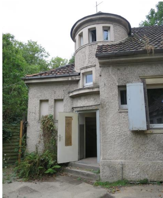
Abb. 10: Verwalterhaus Südfriedhof, Treppenturm und Außenfassade von Nordosten Aufnahme: DLBW/Kirchhoff, 2016
