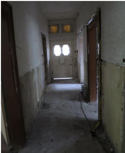
Abb. 12: Verwalterhaus Südfriedhof, Flur und Eingangstür von Südosten Aufnahme: DLBW/Kirchhoff, 2016
