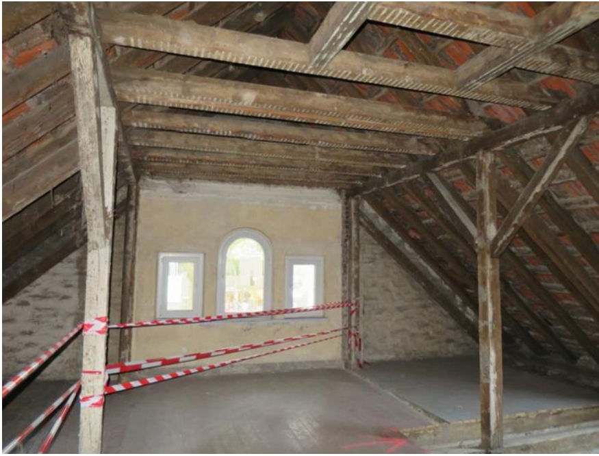
Abb. 14: Verwalterhaus Südfriedhof, Dachgeschoss von Südosten Aufnahme: DLBW/Kirchhoff, 2016
