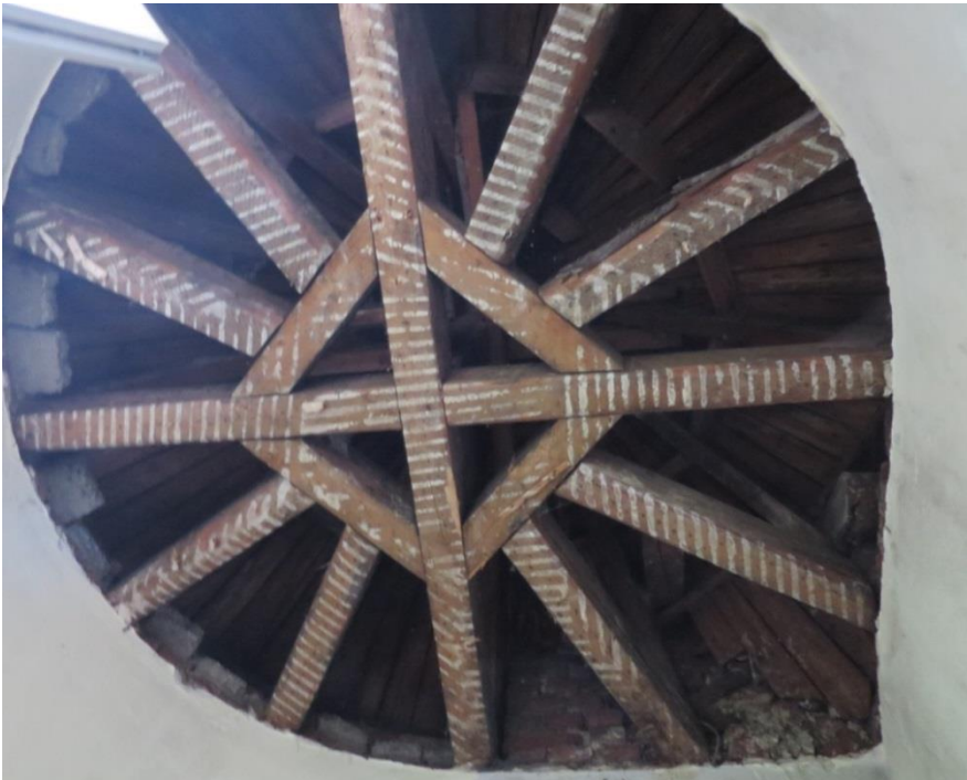
Abb. 15: Verwalterhaus Südfriedhof, Dachkonstruktion Treppenturm Aufnahme: DLBW/Kirchhoff, 2016
