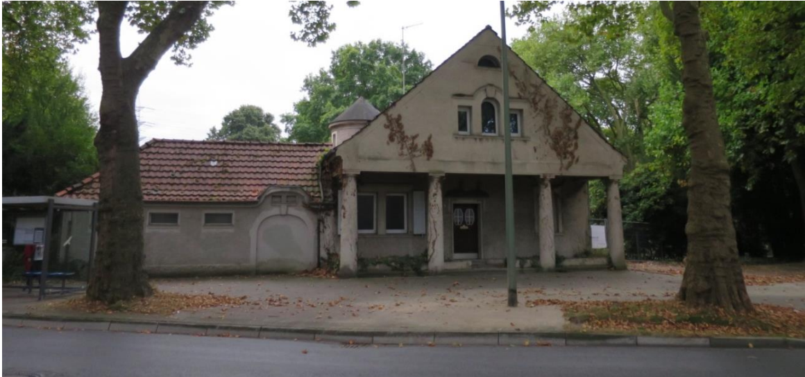
Abb. 05: Verwalterhaus Südfriedhof, Straßenansicht von Nordwesten Aufnahme: DLBW/Kirchhoff, 2016
