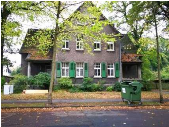
Abb. 1: Straßenansicht des Gebäudes Velsenstraße 18/18a Aufnahme: 2018
