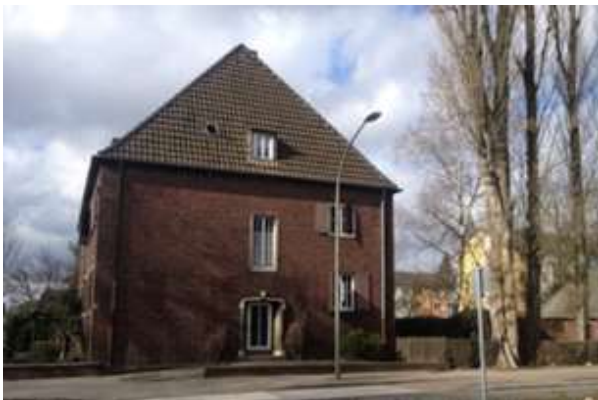
Abb. 2: Fersenbruch 40, Teil des Hauses mit drei Etagenwohnungen für Steiger der Zeche Wilhelmine Viktoria, Eingang an der Grimmstraße Aufnahme: 2016
